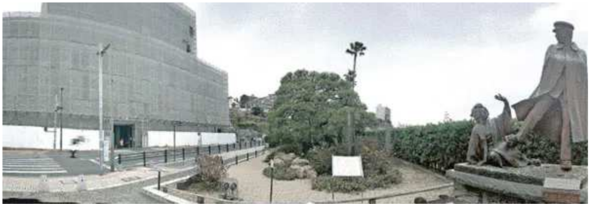
貫一とお宮の像の向かい、かつての「つるやホテル」の跡地に建設中の「熱海パールスターホテル」
